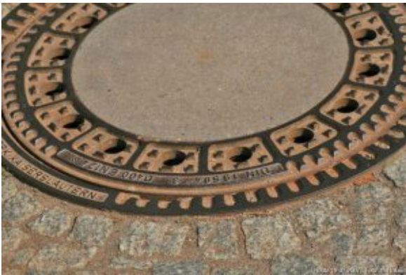
Foto 2: Ein Schachtdeckel sollte in der Regel Löcher haben!
